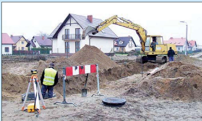
Budowa na Ustroniu
