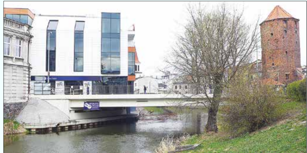
Zbudowany od nowa most przy ulicy Mostowej
