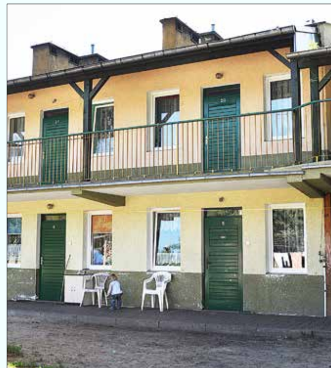
Jeden z domów na osiedlu socjalnym, które stale jest rozbudowywane
