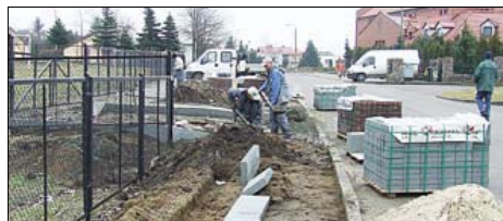
Roboty przy ulicy Szarych Szeregów
