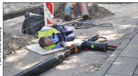
Prace przy budowie sieci ciepłowniczej na ulicy Tylnej
