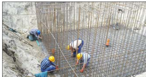
Montaż żelbetonowych konstrukcji dla planowanej fontanny na placie Dużego Rynku
