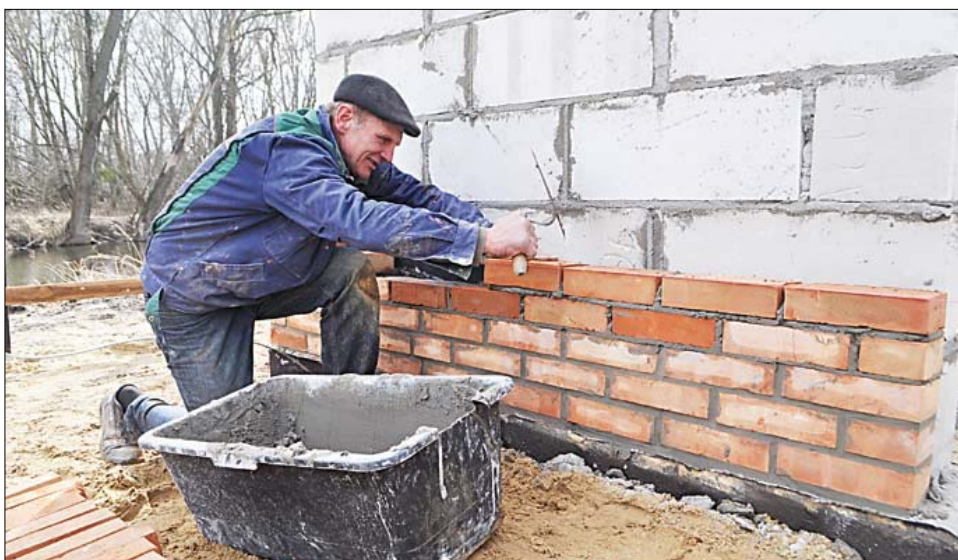
Dawny budynek stacji na zakolu jest właśnie poddawany gruntownej przebudowie
