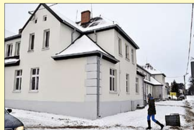
„Belweder” zyskał nową elewację. Wyremontowano gruntownie także dach
