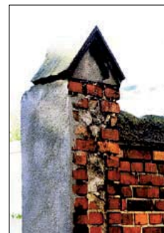
Fragment słupa ogrodzeniowego na ul. Wodnej. Fot. J. Kopiczyński
